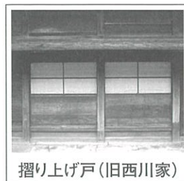
摺り上げ戸(旧西川家)
